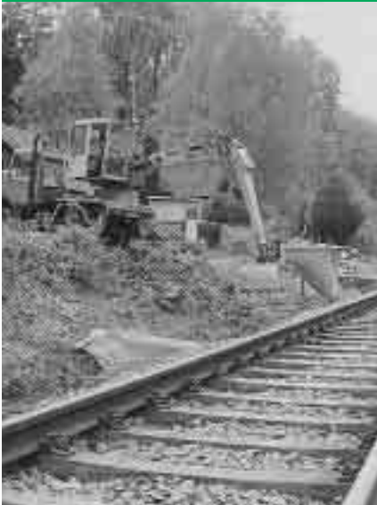
Baustelle Murgtal. Bei der Umwandlung der bisherigen Bundesbahn- in eine Stadtbahntrasse ist der Unimog mit Aufbau- bagger gerade an schwer zu erreichenden Böschungen ein wertvoller Helfer
